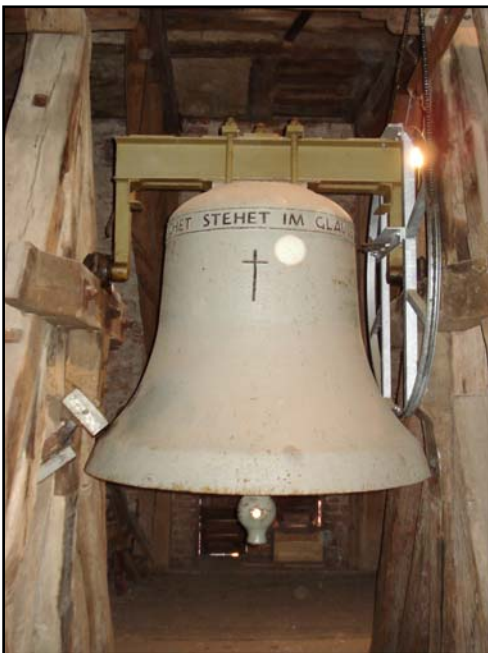
Bild 1452 Glocke 3 (Trauglocke) Südseite links Schlaghammer der Uhr
