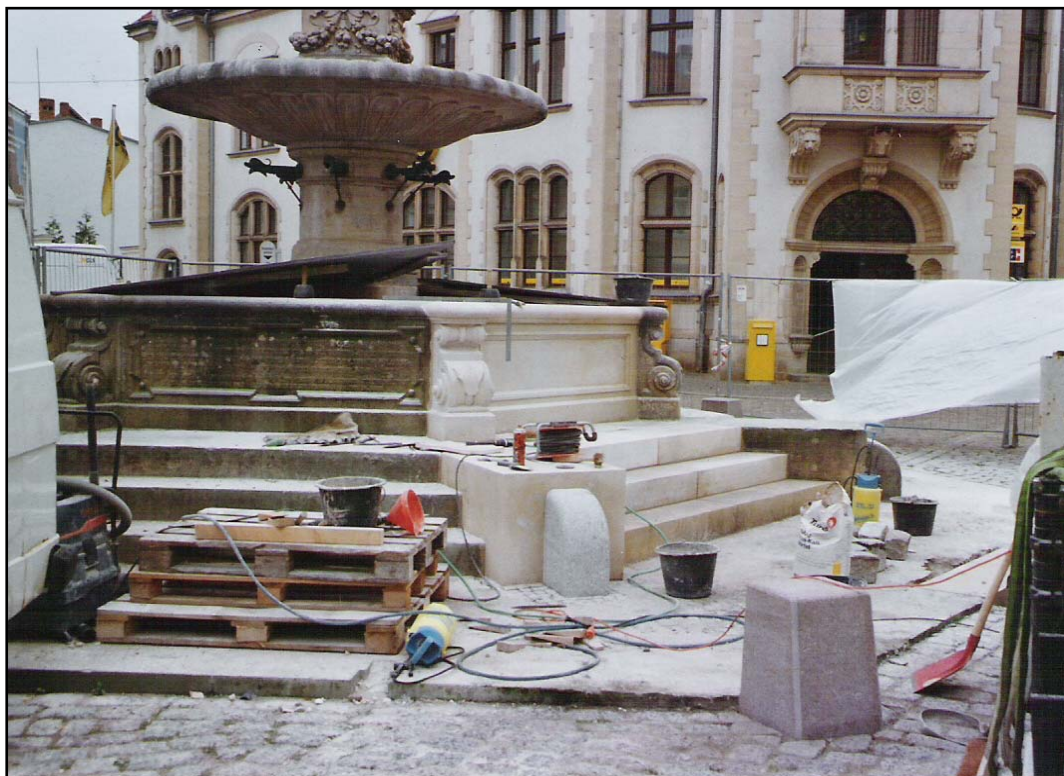
Bild 9; Der reparierte Brunnen am 27.08.2004, kurz vor dem Abschluss der Instandsetzungsarbeiten.
