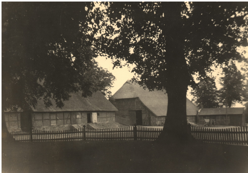
Abbildung 3.8: Das Viehhaus und die Scheune auf dem Gutshof, 1940
