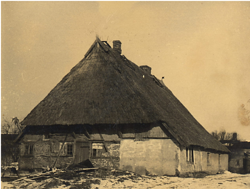
Abbildung 3.5: Das Hallenhaus in der Feldmark an Stelle des Gehöftes II
