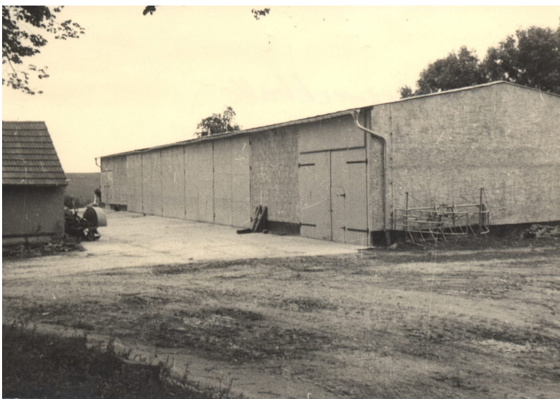
Abbildung 4.9: Die auf dem Gutshof errichtete Mehrzweckhalle und Werkstatt
