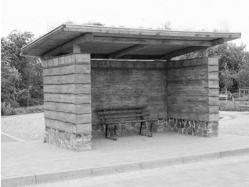
Abbildung 6.14: Die Bushaltestelle in Stampflehmbauweise mit Dachbegrünung in Kirch Mulsow
