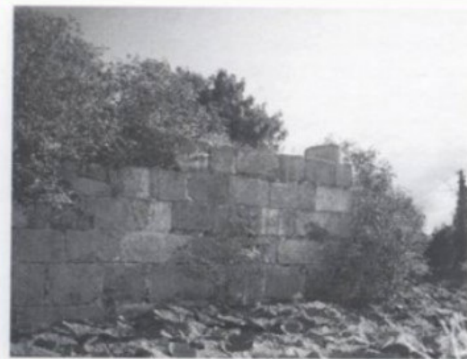
Reste eines Wirtschaftsge- bäudes des Gutshofes Wrangelsburg, das aus Abbruchsteinen des Wolgaster Schlosses errichtet wurde
