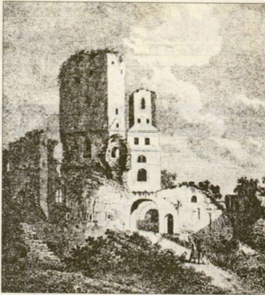
Schon 1711 begannen die ersten Abbrucharbeiten an der Wolgaster Schlossruine.
