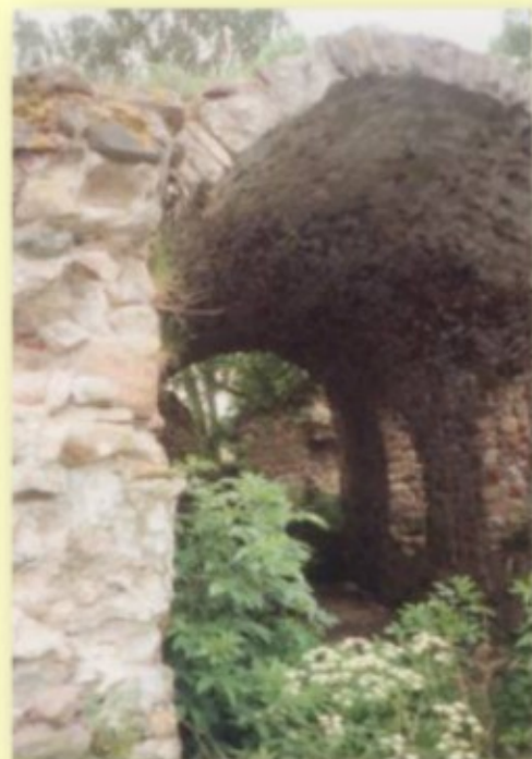
Reste des Turmunterbaues
