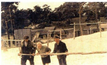
Mit Körperkraft wird die Bockwinde gedreht
