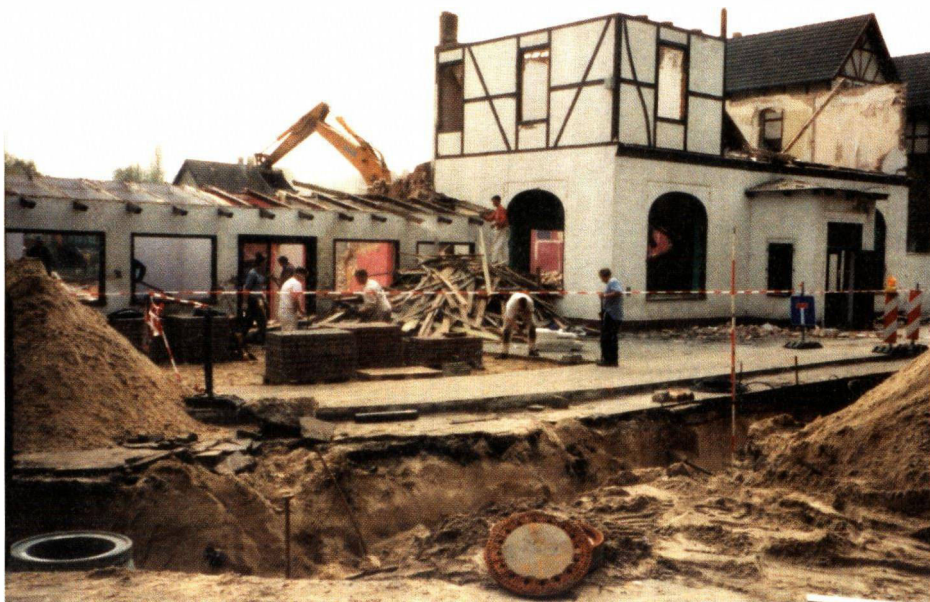
1996 Abriss und Einbau der Kanalisation in der Waldstraße
