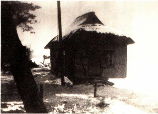
Nach der Sturmflut 1971 – Toilettengebäude am Strand
