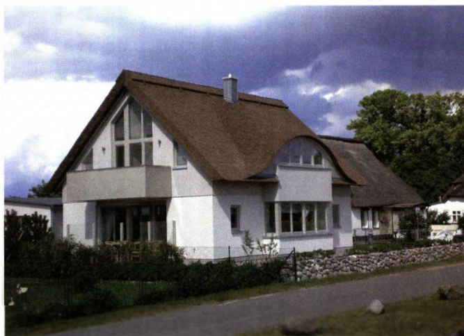
Das erste Dach mit Kunstrohr im Ort
