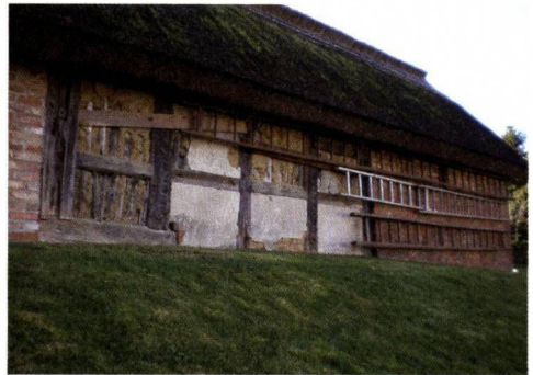
Zickenberg – Fachwerk mit Lehmstaken und Rohrdach – die ursprüngliche Bauweise in Zempin – der einseitige Überstand des Firstes ist zu erkennen
