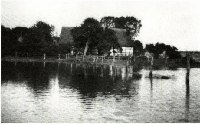
Hochwasser auch am Achterwasser 1954 ohne Deich stand das Wasser bis an den Lüderhof / Ausbau
