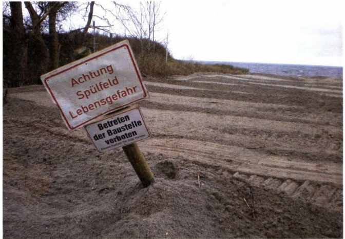
Sofortmaßnahme aufspülen von Dünen 2006
