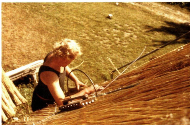
Arbeitsgeräte: Rundnadel und Dachbrett
