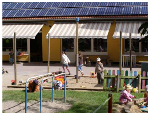
Abb. 43: Blick auf die Einrichtung mit Solaranlage
