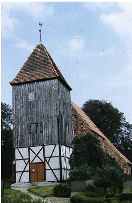
Abb. 28: Die Retschower Kirche mit ausgemauertem Fachwerk vor etwa 25 Jahren Foto: A. Schmidt
