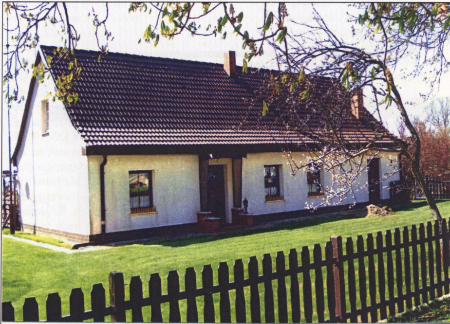
Siedlungshaus Nummer 3 um 2013 nach Sanierung
