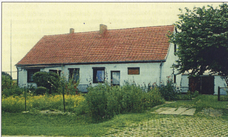
Siedlungshaus Nummer 4 in Ost-Klüne saniert
