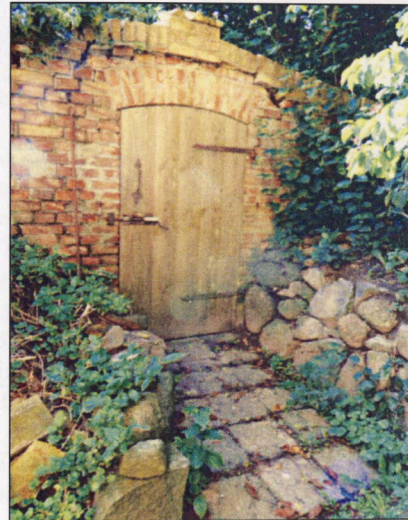
Eingang zum Erdkeller (rechts) Glockenschornstein im Bereich des Dachbodens (andere Seite)
