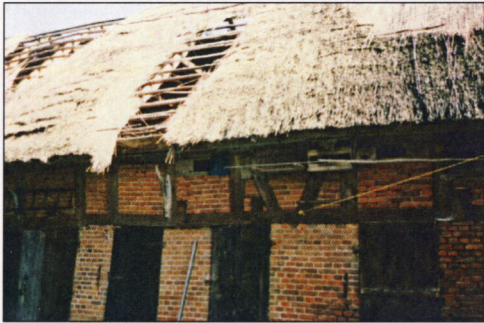
Alte Fachwerkbauweise (oben)
