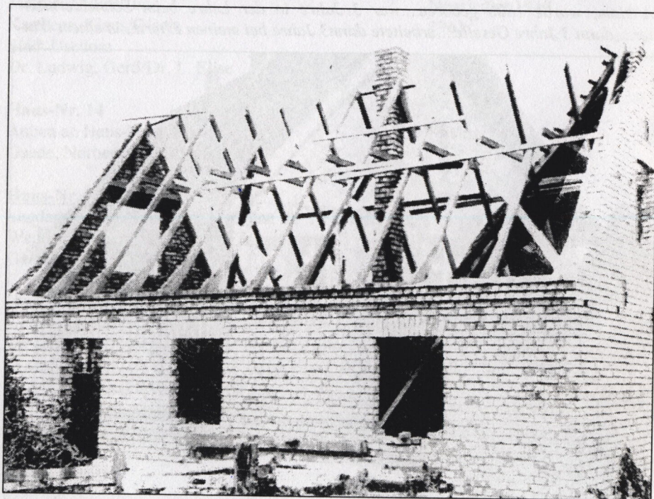
Nebengebäude zur Schule mit Klassenraum im Obergeschoss
