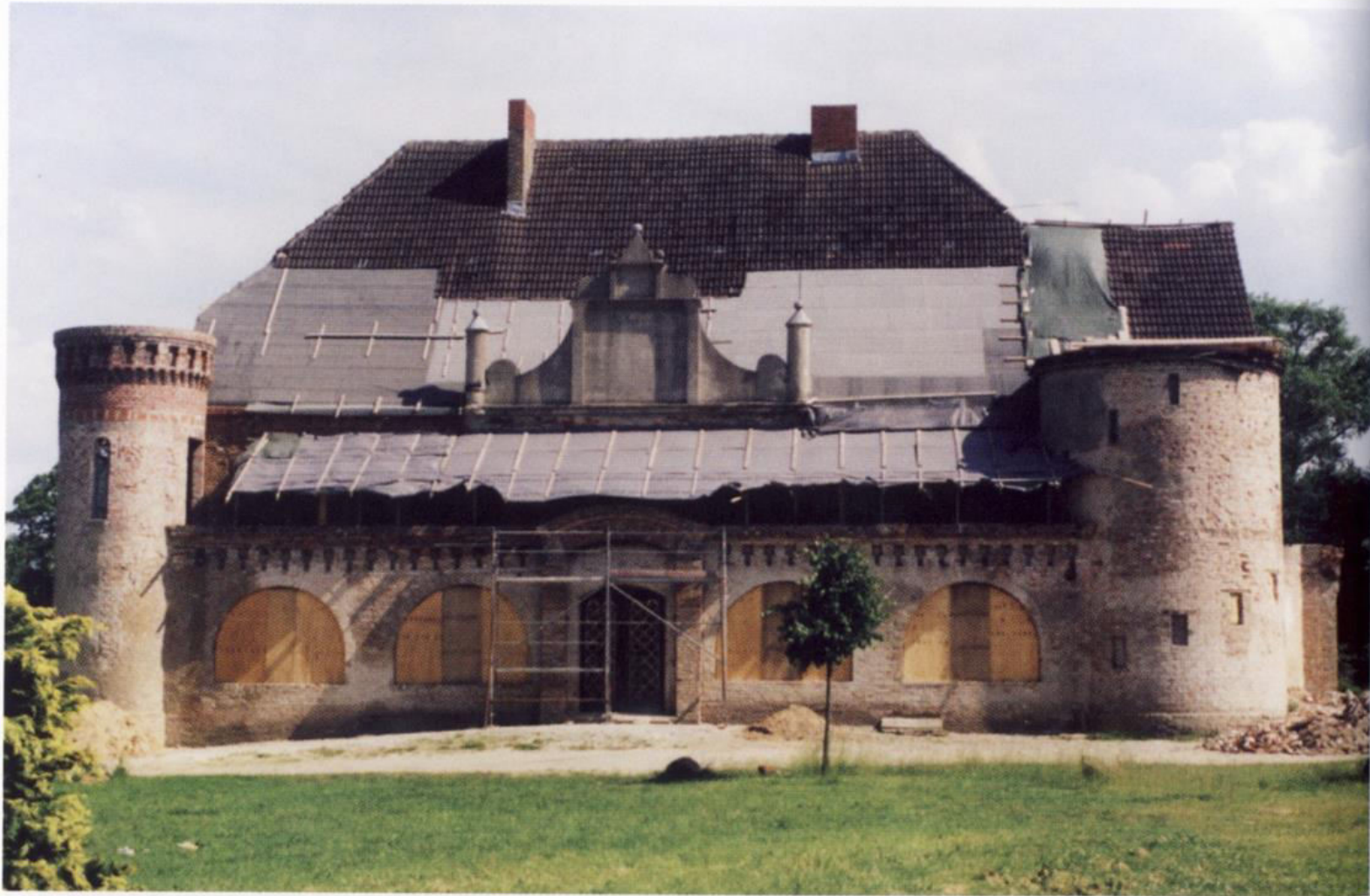
Abb. 6: Schloss, Hauptfront, Juni 2002 nach der Mauerwerksanierung und Beginn des 2. Bauabschnittes „Dachsanierung“ sowie Sanierung des Arkadenganges
