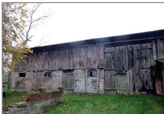
Abb. 52: Scheune mit ehem. Stallnutzung, Hof Knoll (Foto 2014)
