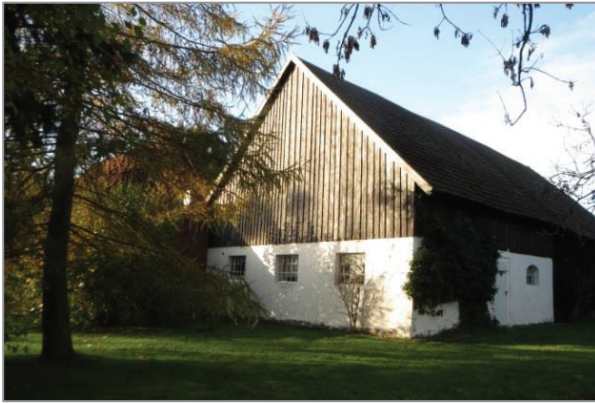
Abb. 12: Grundstück 5, Stallscheune der Neubauern-Siedlung Sievert
