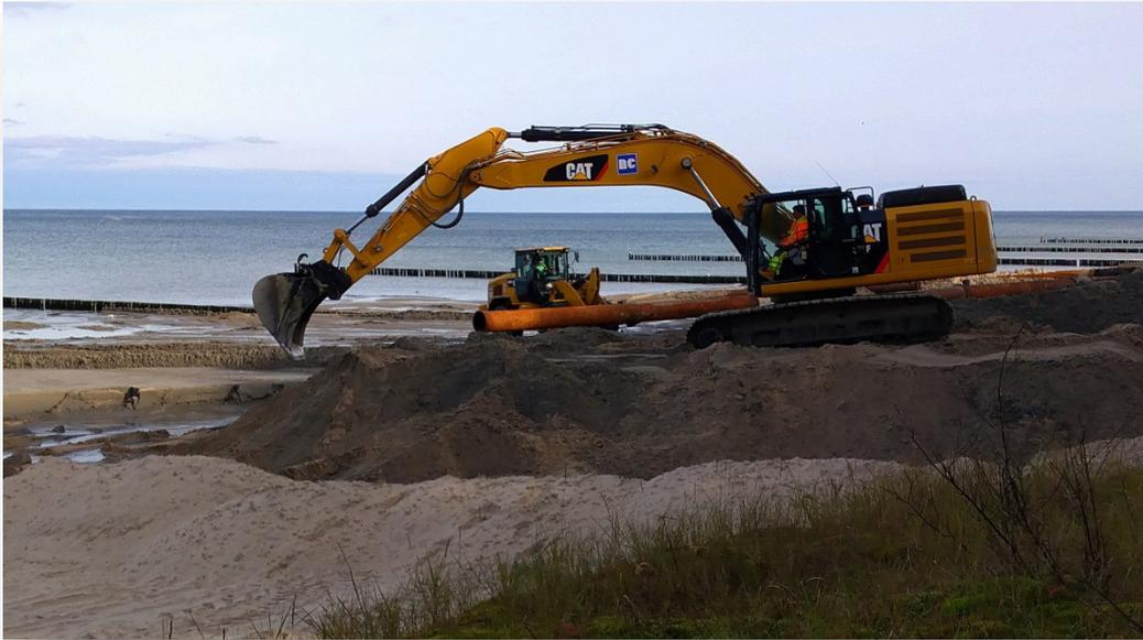
Der Bagger gräbt eine Wanne, in der das Sand-Wassergemisch ankommt und sich der Sand setzen kann. Das übrige Wasser fließt in einer Rinne wieder ins Meer. Man beginnt an der am weitesten Entfernung der Aufschüttung vom Anfahrtsrohr und baut die Rohre entsprechend wieder ab. So kann man in beide Richtungen einen großen Strandabschnitt erreichen.
