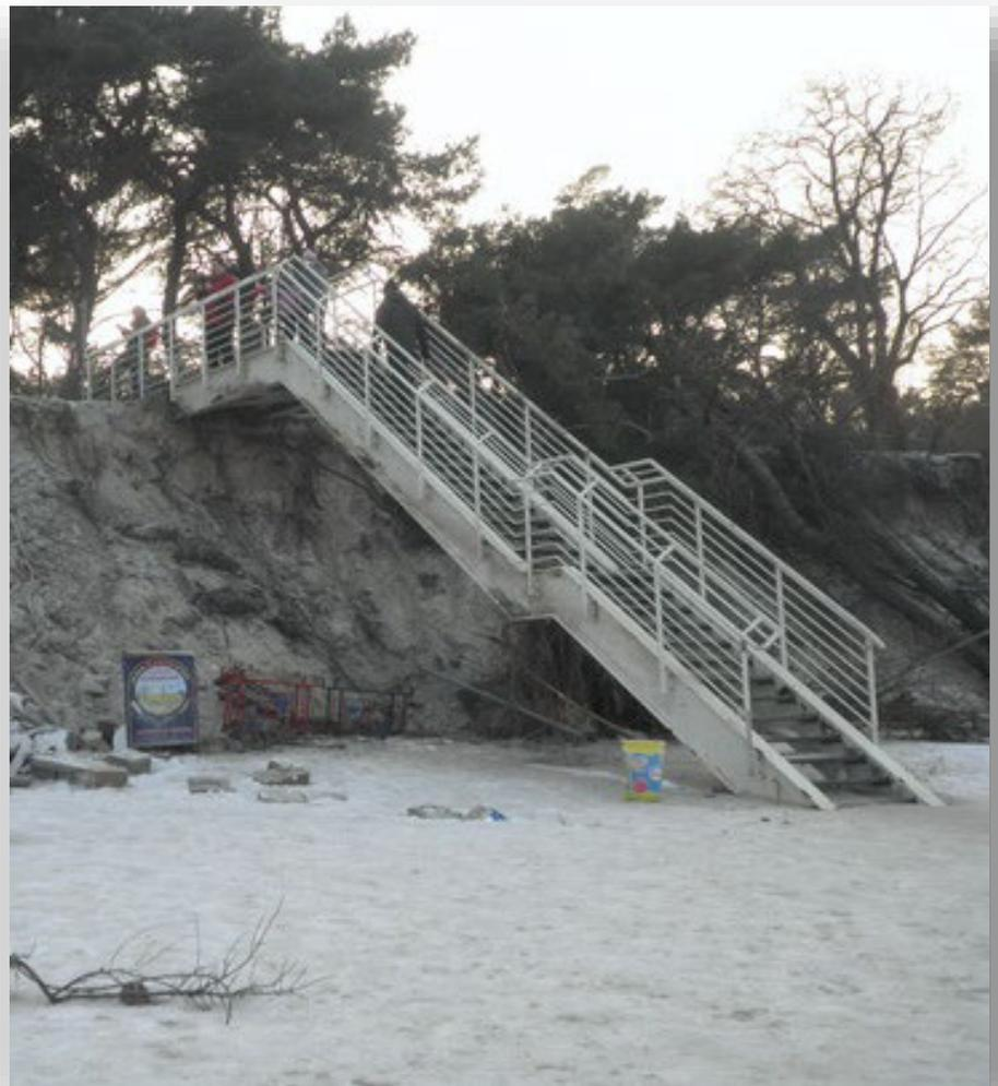
Die Eisentreppe in Zempin wurde nach der Sturmflut 1995 mit Fördermitteln gebaut. Am 05.01.2017 – nach einer Sturmnacht hatte sie noch guten Halt. Sie kann bei weiteren Abbrüchen mit einem Krahn auch versetzt werden.
