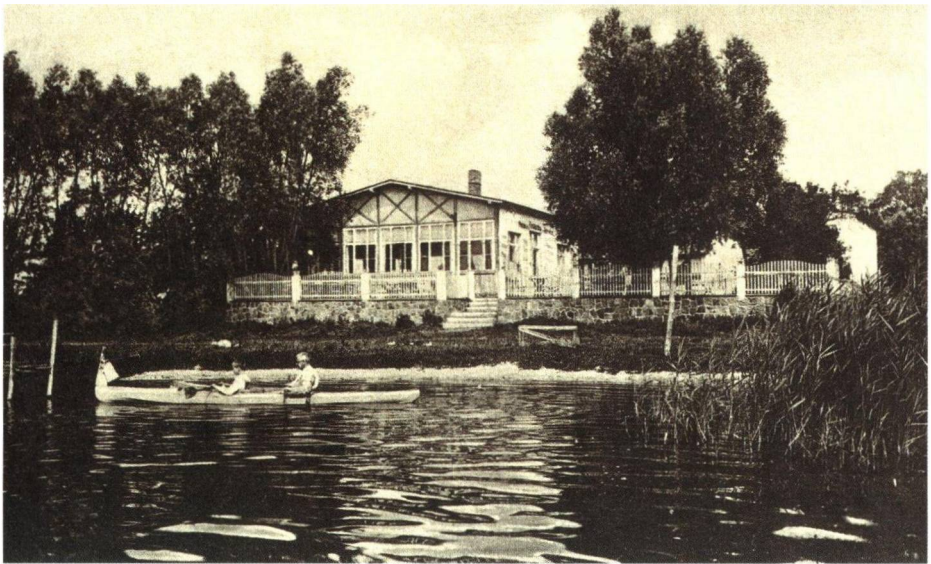
Ansicht vom Achterwasser
