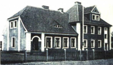
Drittes Schulgebäude, Ansichtskarte von 1929
